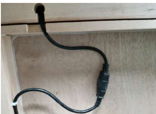
(1) Podłącz złącza przewodów promienników, upewniając się, że kable nie są przyciśnięte pomiędzy panelem sufitowym a innymi panelami
